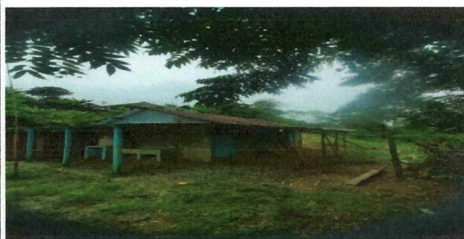
Foto 4: Reparación de áreas de cocina en instalación de puertas, ventanas, cambio de techo, repellar pared, fundir torta y reparar techo corredor, incluyendo entortada.
