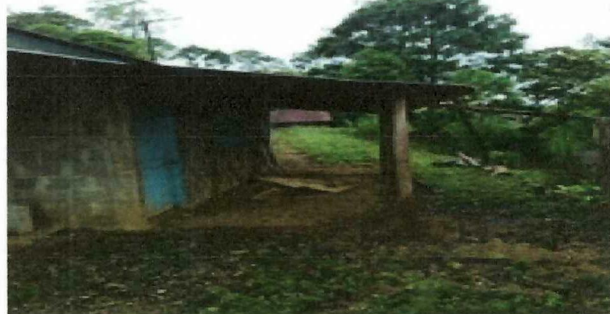
Foto 5: Instalación de cubierta de lámina, losa de patio y reparación de columnas de corredor.
